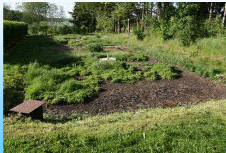
Złoża piaskowe o przepływie pionowym działające naprzemiennie
