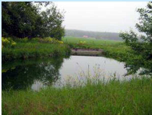
Staw wodno-roślinny z chemicznym strącaniem fosforu
