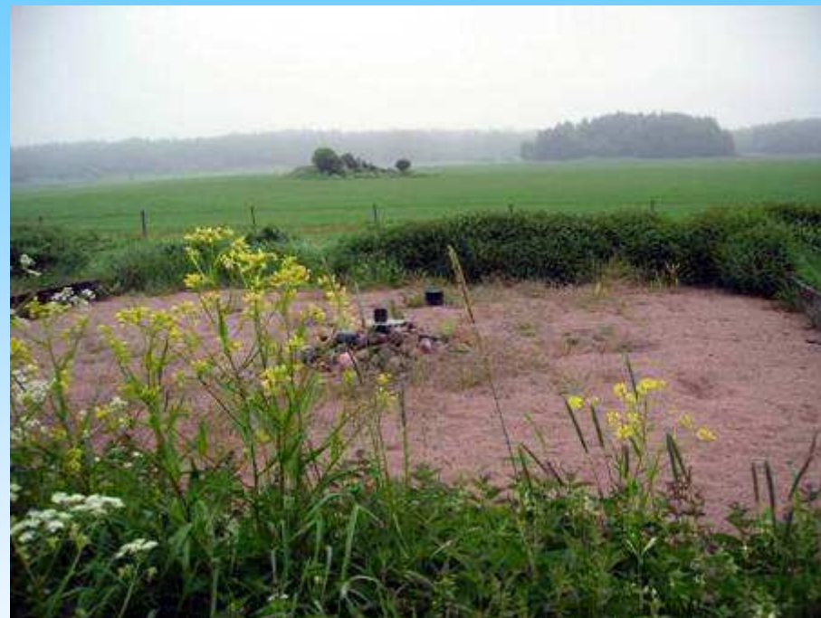
Widok złoża piaskowego z rurowym dystrybutorem ścieków
