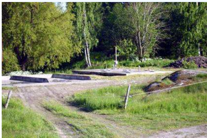
Osadnik wielokomorowy oraz poletka osadowe
