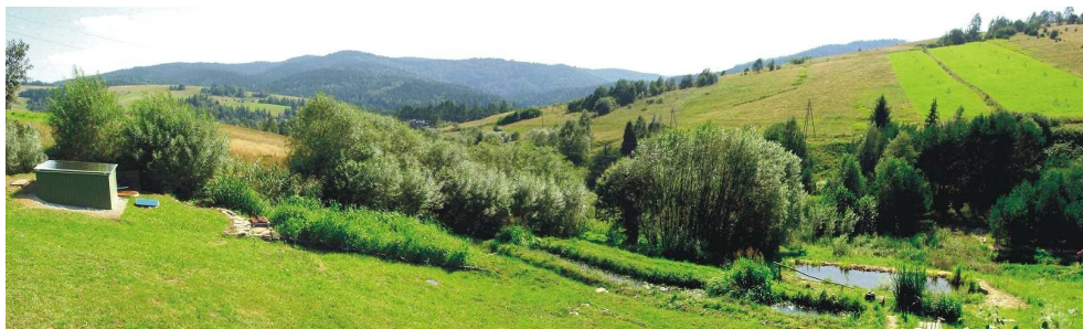
Oczyszczalnia w ośrodku IBMER w Tyliczu
