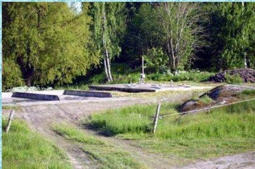
Osadnik wielokomorowy oraz poletka osadowe
