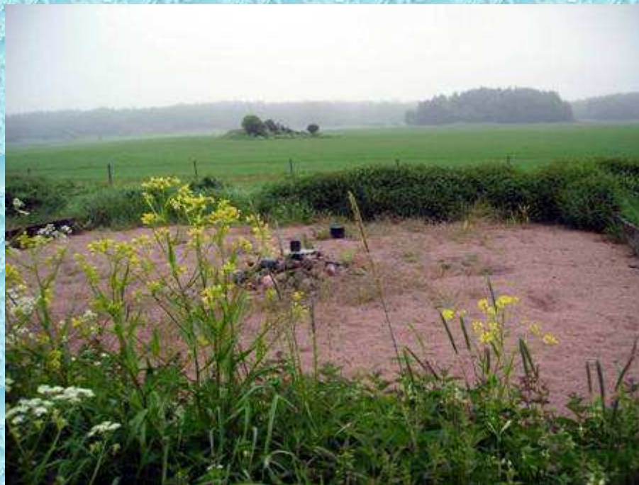
Widok złoża piaskowego z rurowym dystrybutorem ścieków
