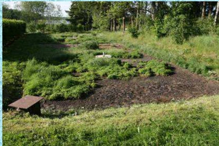
Złoża piaskowe o przepływie pionowym działające naprzemiennie
